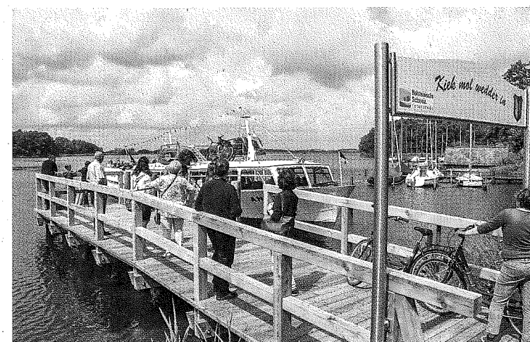
Der alte Fähranleger in Bosau war nicht mehr zeitgemäß und wurde ersetzt. Dabei wurde vor allem auf Barrierefreiheit geachtet. Auch in Rothensande am Kellersee wird ein Fähranleger gebaut.
